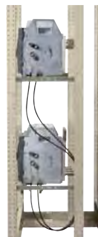
Блокировка двух выключателей Masterpact гибкими тросиками
